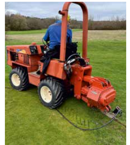
Einzugsflug, Steuerkabel zum Regner
