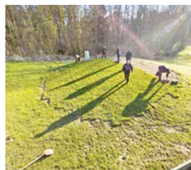
Verlegung von Rollrasen am Tee 11
